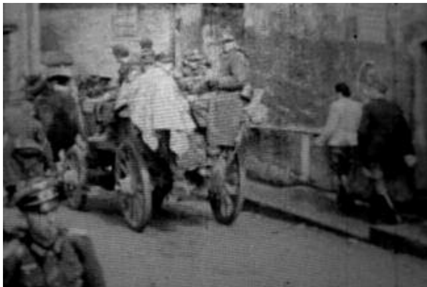
Reste der Wehrmacht flohen in Richtung Teisendorf.
