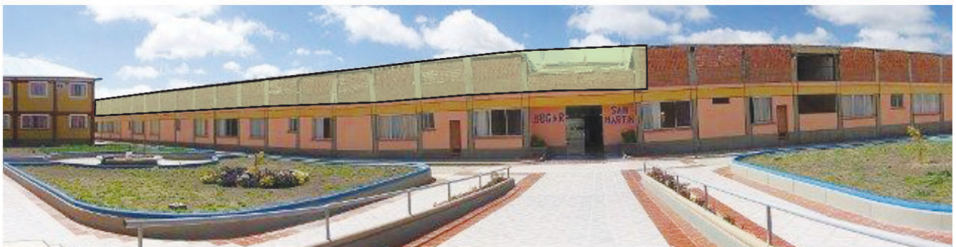
Links: das Schwesternhaus, daneben das Bettenhaus (112 m lang) mit provisorischer Aufmauerung und Pultdach.
