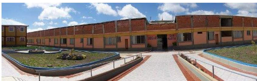
Hier im ersten Stock die bisherige provisorische Außenwand mit provisorischem Pultdach.
