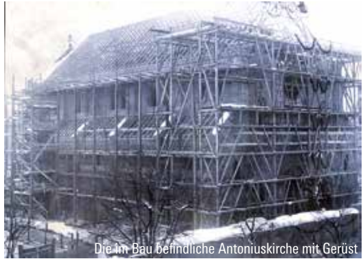
Die im Bau befindliche Antoniuskirche mit Gerüst
