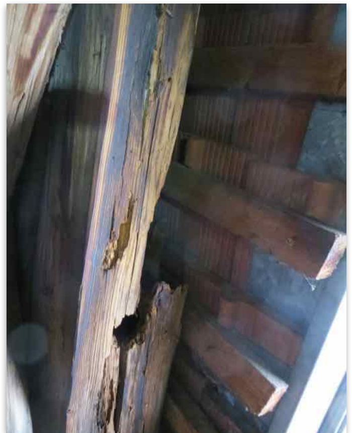
Foto: ein verfallener Dachbalken, der nach der Entschuttung entdeckt wurde
