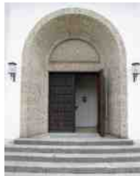
Portal zur Pfarrkirche Vaterstetten
