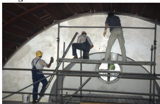
Mühsam wurde die verrußte Kalkfarbe entfernt und die Wände neu geweißelt
