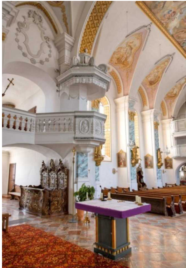
Bild3: Barocker Kirchenraum mit Wandpfeilern und Stichkappen. Links die frühere Sakristei
