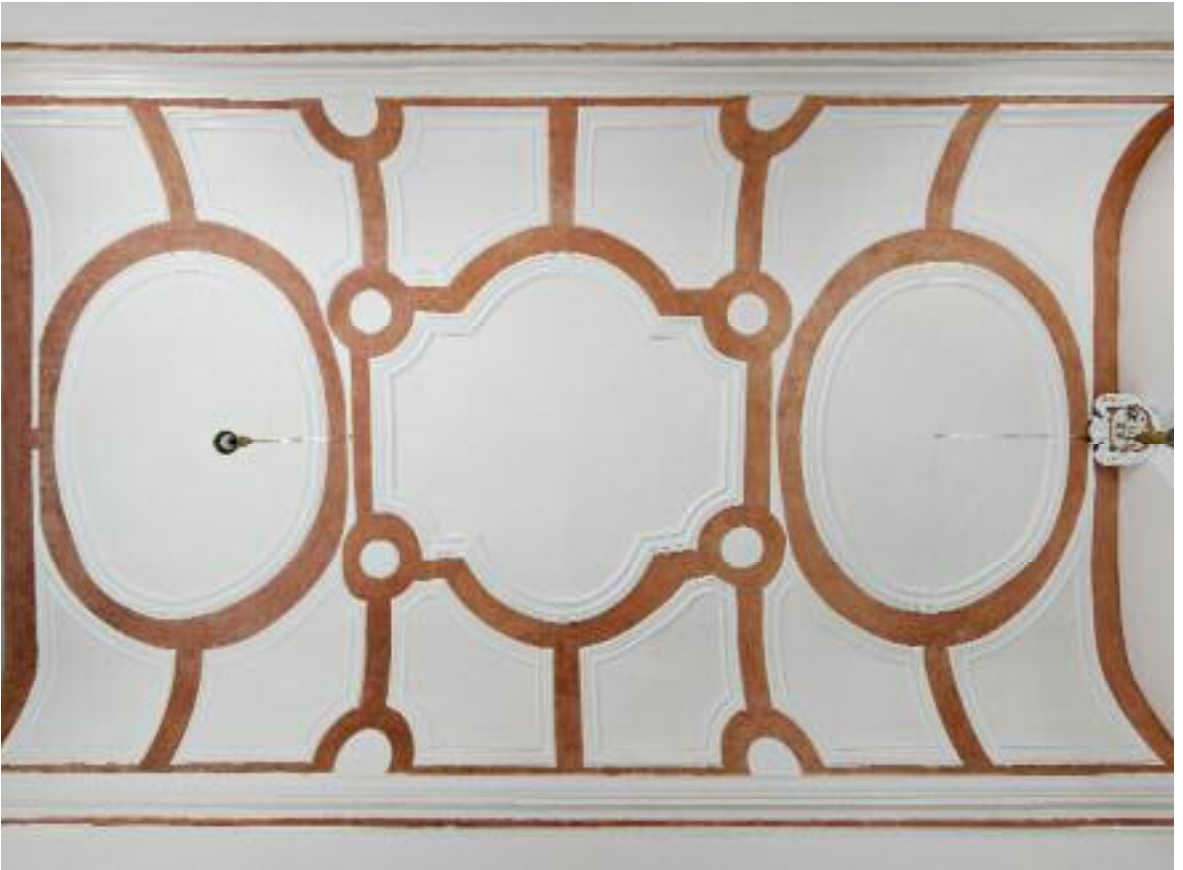
DECKE IM HAUPTRAUM. SCHLUSSZUSTAND
