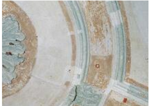
STUCKFASSUNG IM PRESBYTERIUM, VORZUSTAND, DETAIL
