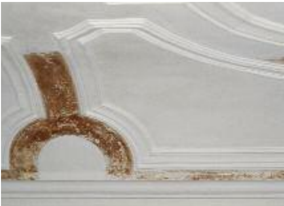
HAUPTRAUMDECKE, FREIGELEGT, DETAIL
