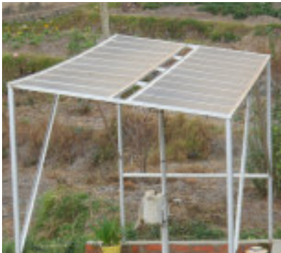
Zisterne und Solaranlage zum Betrieb der Pumpen
