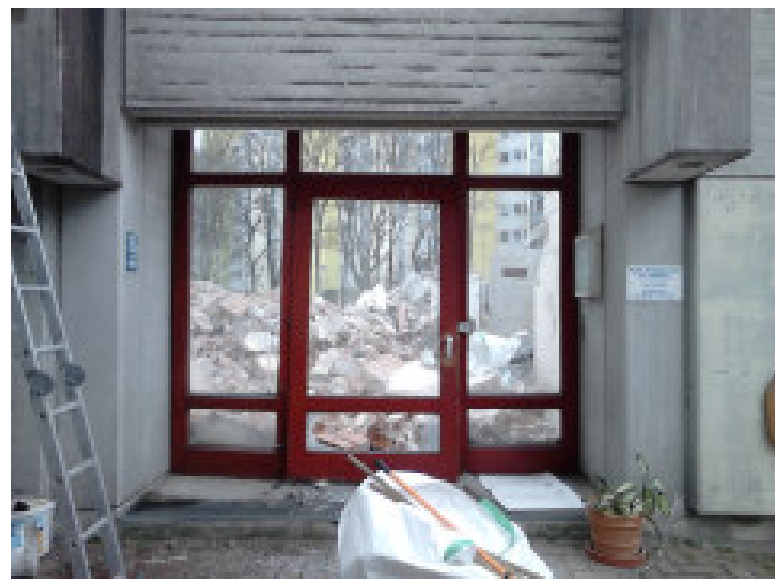
Abbruch des alten Kindergartens ???
