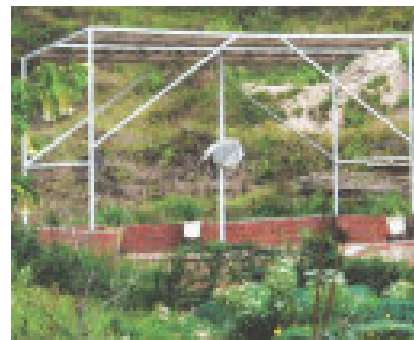
Die neue Wasserversorgungsstation des Brunnenprojekts in Tansania Foto: Felizitas Kanthack
