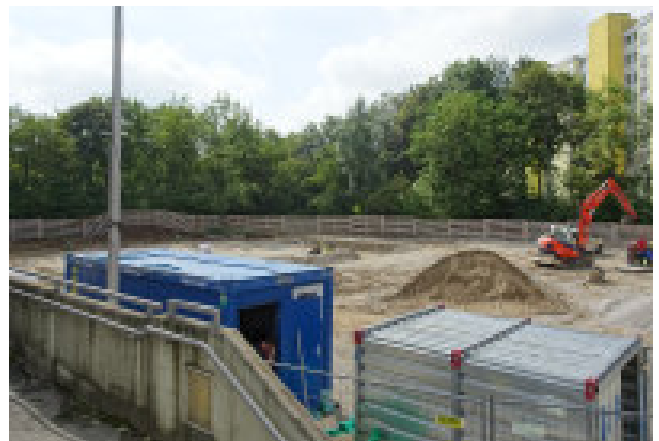
Baustelle Ende Juli 2016
