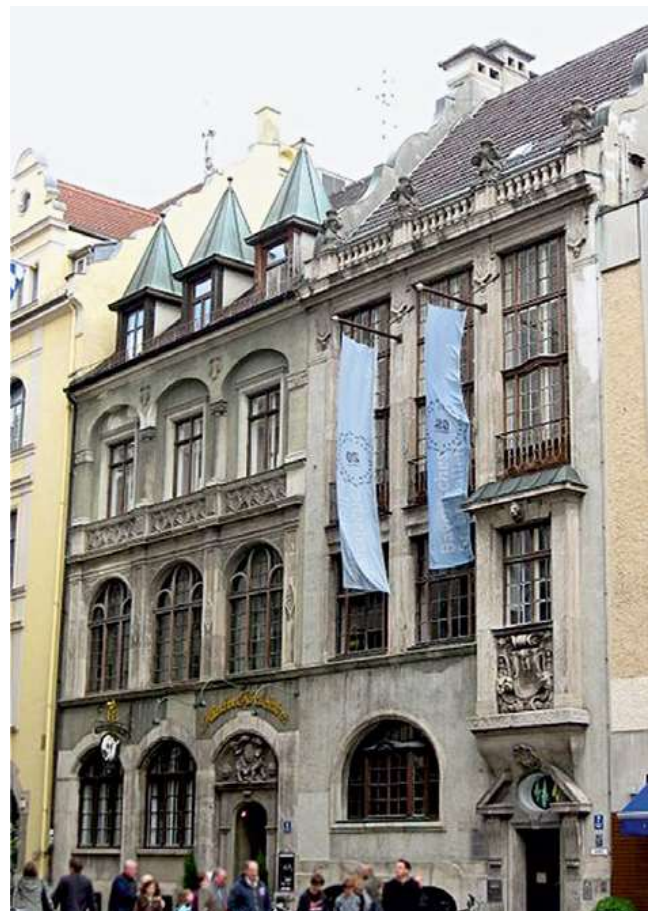
Gebäude Frankonia heute Staatsballett
