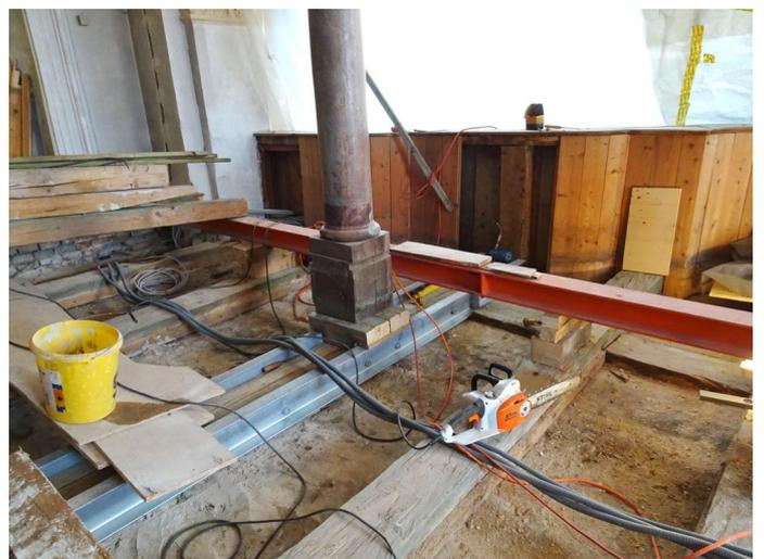
**Foto rechts: Verbesserung der Statik auf der ersten Empore durch Einbau zusätzlicher Stahlträger und Balken**
