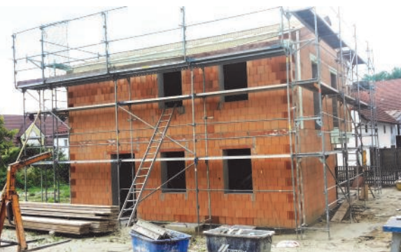
Der Rohbau wächst.
