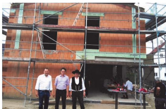
Richtfest mit Architekt Rückert, Peter Mareis und Zimmerer.
