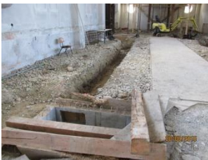
Kanäle und Schächte für eine moderne Luftheizung die nahezu stehende Luftsäulen erzeugen wird.
