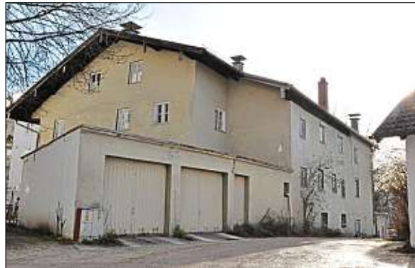
Die Garagen und jüngeren Anbauten hinter dem Haus sollen abgerissen werden (Foto oben). Auf dem Kupferstich, der eine Stadtansicht von 1705 zeigt, ist das ehemalige Baderanwesen bereits als dreigeschoßiges Gebäude zu sehen.
