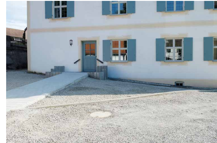
Der verunkrautete Oberboden wurde entfernt und mit Kies ausgetauscht
