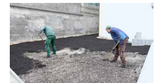
Der Kompost wird gleichmäßig verteilt und oberflächlich eingearbeitet.
