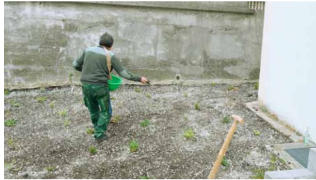
Zum Schluss erfolgt die Ansaat kreuzweise per Hand in zwei Durchgängen.
