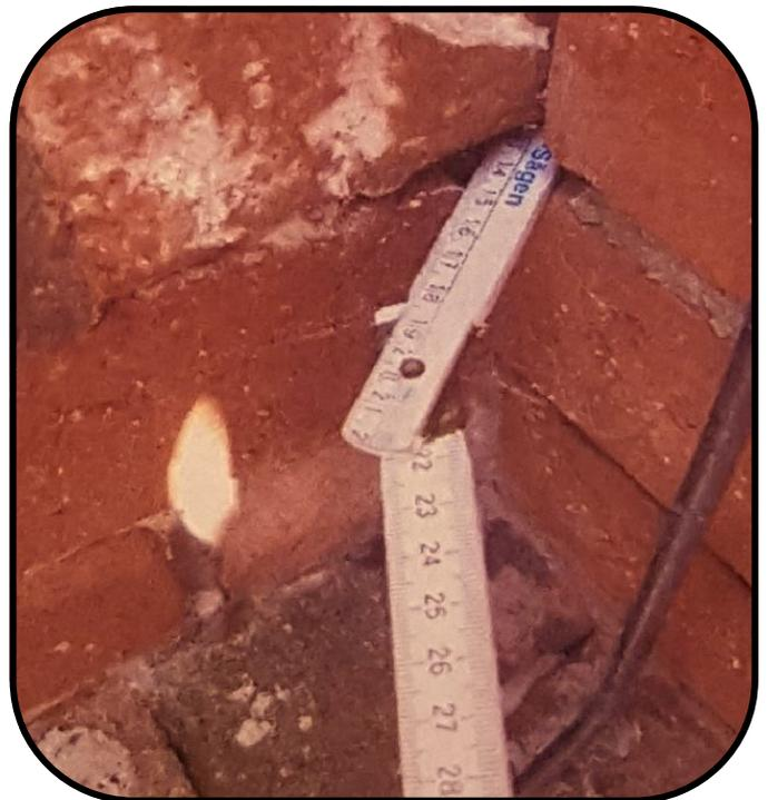
Hier im Bild können Sie, als Beispiel für die festgestellten Schäden, eine 14 Zentimeter lange offene Fuge erkennen und sich eine Vorstellung von den Schäden machen!
