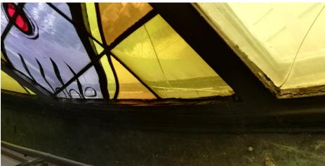
Dieser Glasschaden wäre für sich genommen relativ einfach zu reparieren und er wird auch von der Versicherung übernommen. Bei der Be-gutachtung durch zwei Fachfirmen stellte sich aber heraus, dass an dem Fenster weit gravierendere Schäden vorliegen, hauptsächlich verursacht durch Rost und einen Hitzestau zwi-
