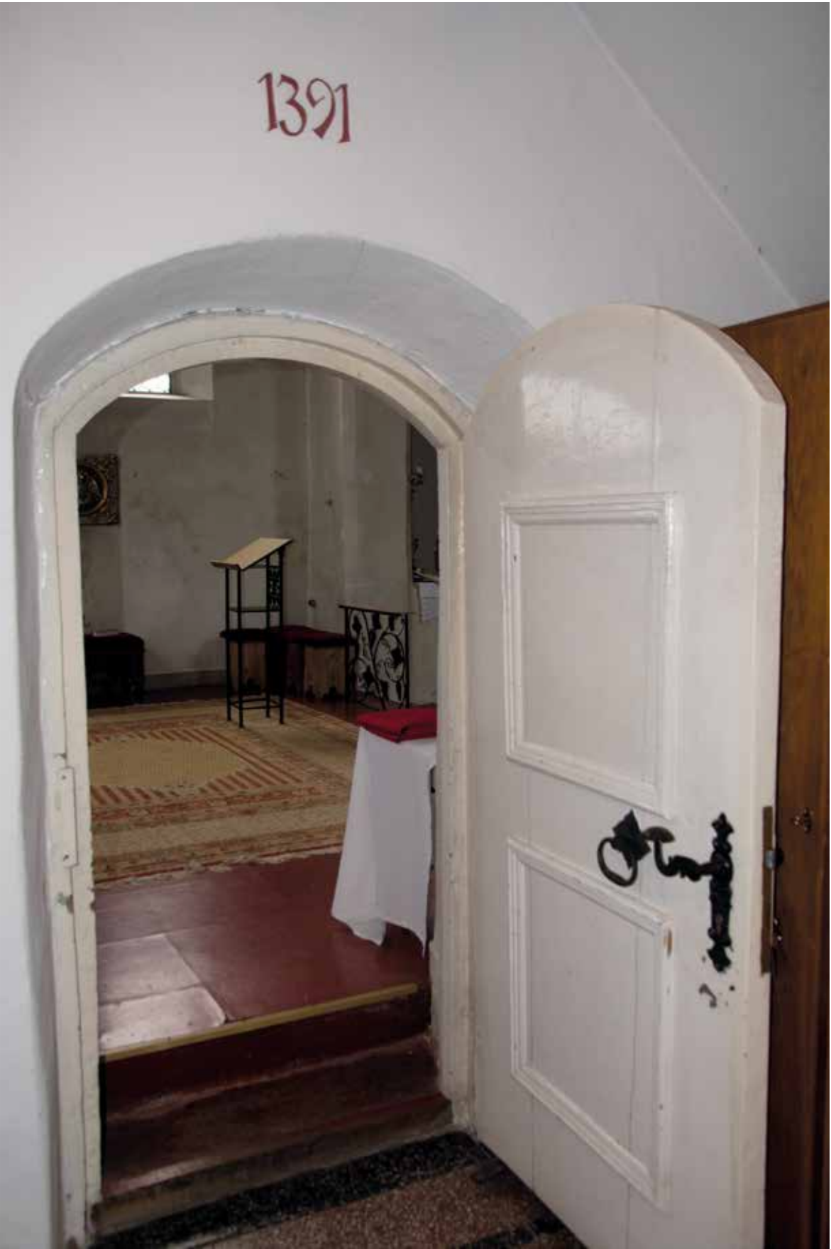
Auf diesem Foto ist der Zugang von der Sakristei aus in die Kirche in Lindach zu sehen. Der Altar der Kirche wurde 1420 also vor 600 Jahren geweiht. Die jetzige Kirche ist ein Ersatzbau. Die Jahreszahl 1391 über der Türe lässt vermuten, dass dies der Baubeginn der neuen Kirche war.
