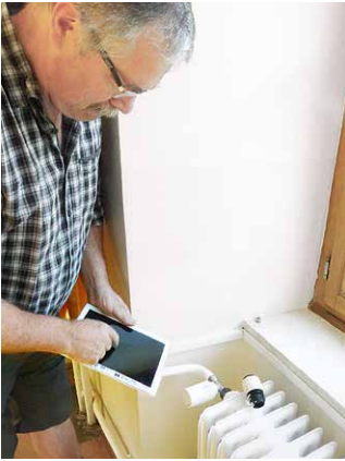
Einbau elektronischer Thermostate zur effizienteren Heizungssteuerung (Hausmeister Johannes Janßen, Juni 2018)
