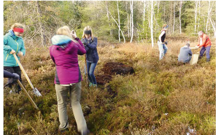
Staudammbau im Königsdorfer Weidfilz, Einschlagen von Staubrettern in einem ehemaligen Entwässerungskanal (Dezember 2019)
