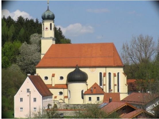
Bild 1 Pfarrkirche St. Leonhard, Südansicht
