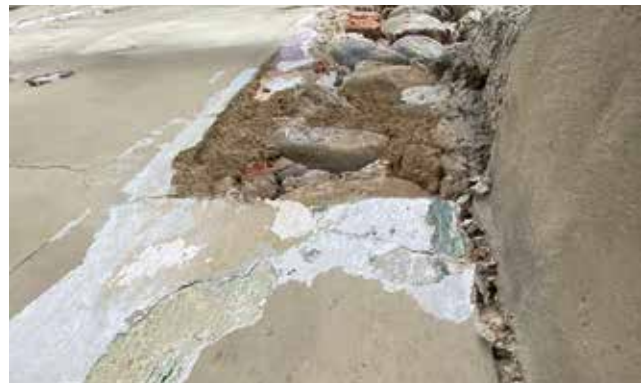
01 und 02: Freigelegter instabiler Bereich der Nordostecke mit Pfeileransatz
