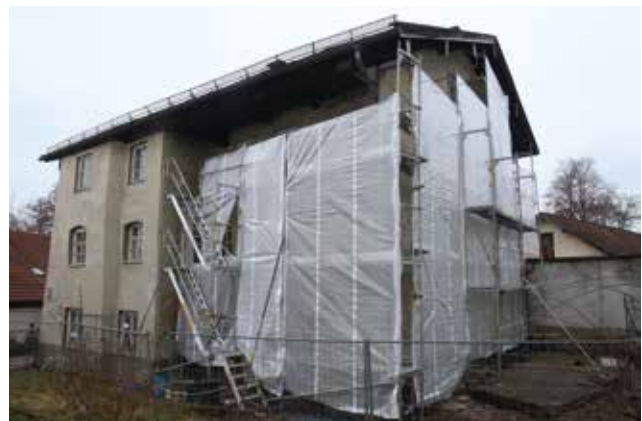
03: Das Gerüst dient zum Abnehmen des Putzes und für die Arbeiten zur statischen Ertüchtigung
