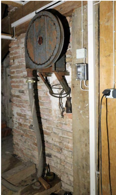
*Kirchenspeicher. Dieses Gebläse wurde an Pfingsten 1952 von Franz Faltermaier an die Westmauer der Kirche montiert. Der nach unten hängende flexible Schlauch wurde durch das Deckengewölbe der Kirche geführt und mit dem Blasbalg verbunden.*
