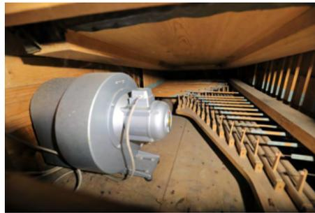
*Gebläse. Bei der letzten Restaurierung der Orgel wurde das alte Gebläse im Kirchenspeicher gegen ein neues Gebläse ausgetauscht. Die in das Orgelgehäuse eingebaute Windversorgung hat den Vorteil, dass Luft mit der gleichen Temperatur in die zum Teil aus Holz bestehenden Pfeifen geblasen wird, wie sie in der Kirche herrscht.*
