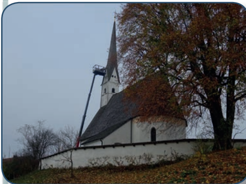
St. Margaretha Reparatur am Kirchturm
