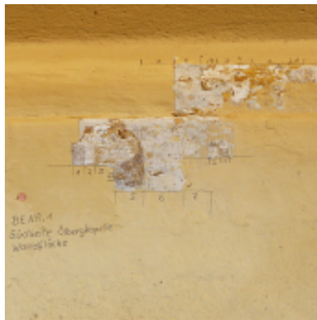
Befund der Fassadenuntersuchung
