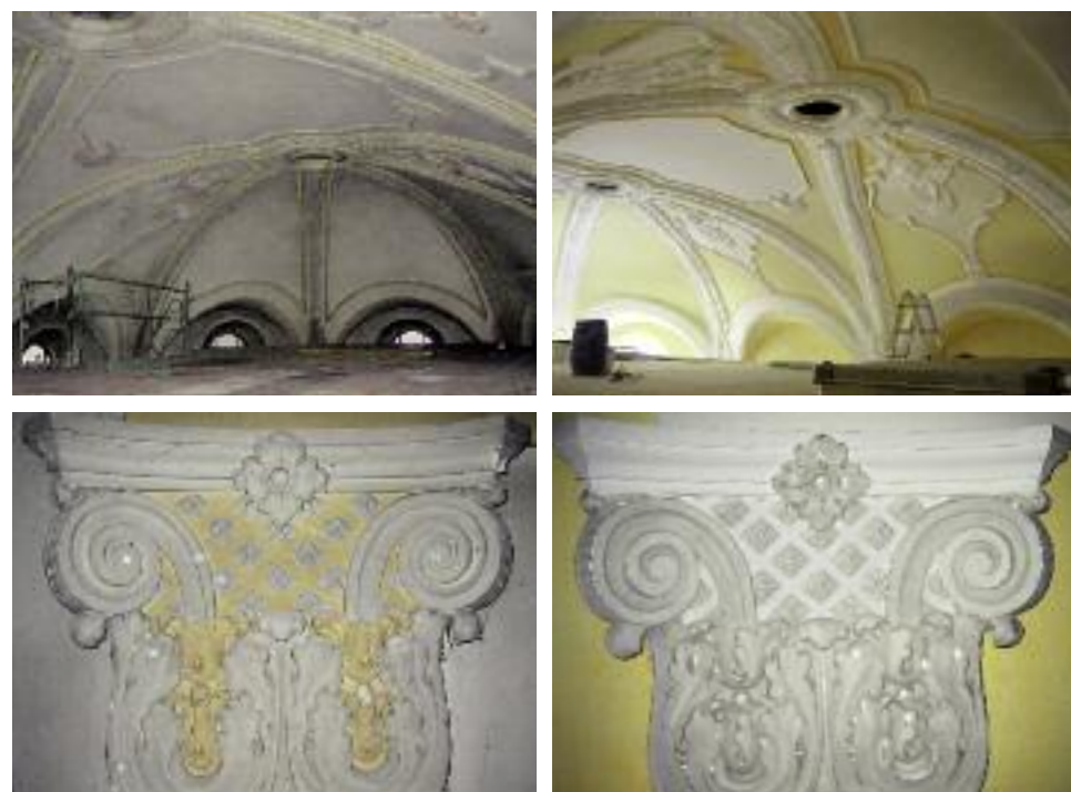
RAUMSCHALE DETAIL VORZUSTAND
