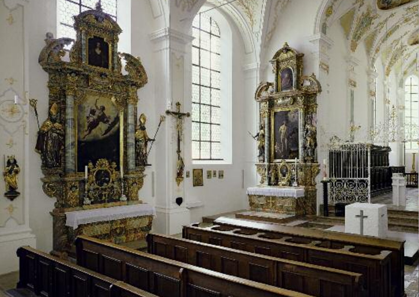
LANGHAUS NORDSEITE, ENZUSTAND
