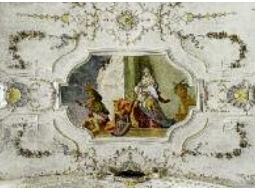
LANGHAUSGEWÖLBE DETAIL, VORZUSTAND
