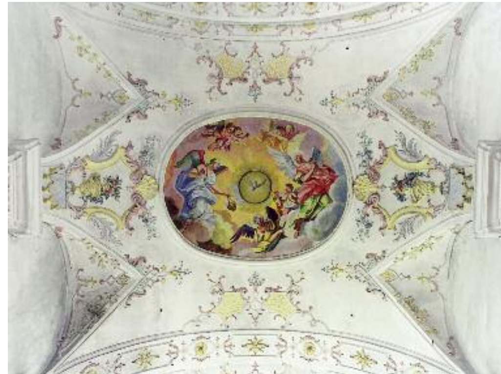
CHORGEWÖLBE DETAIL, VORZUSTAND
