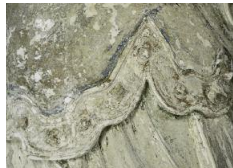
FREIGELEGT UND GEKITTET
