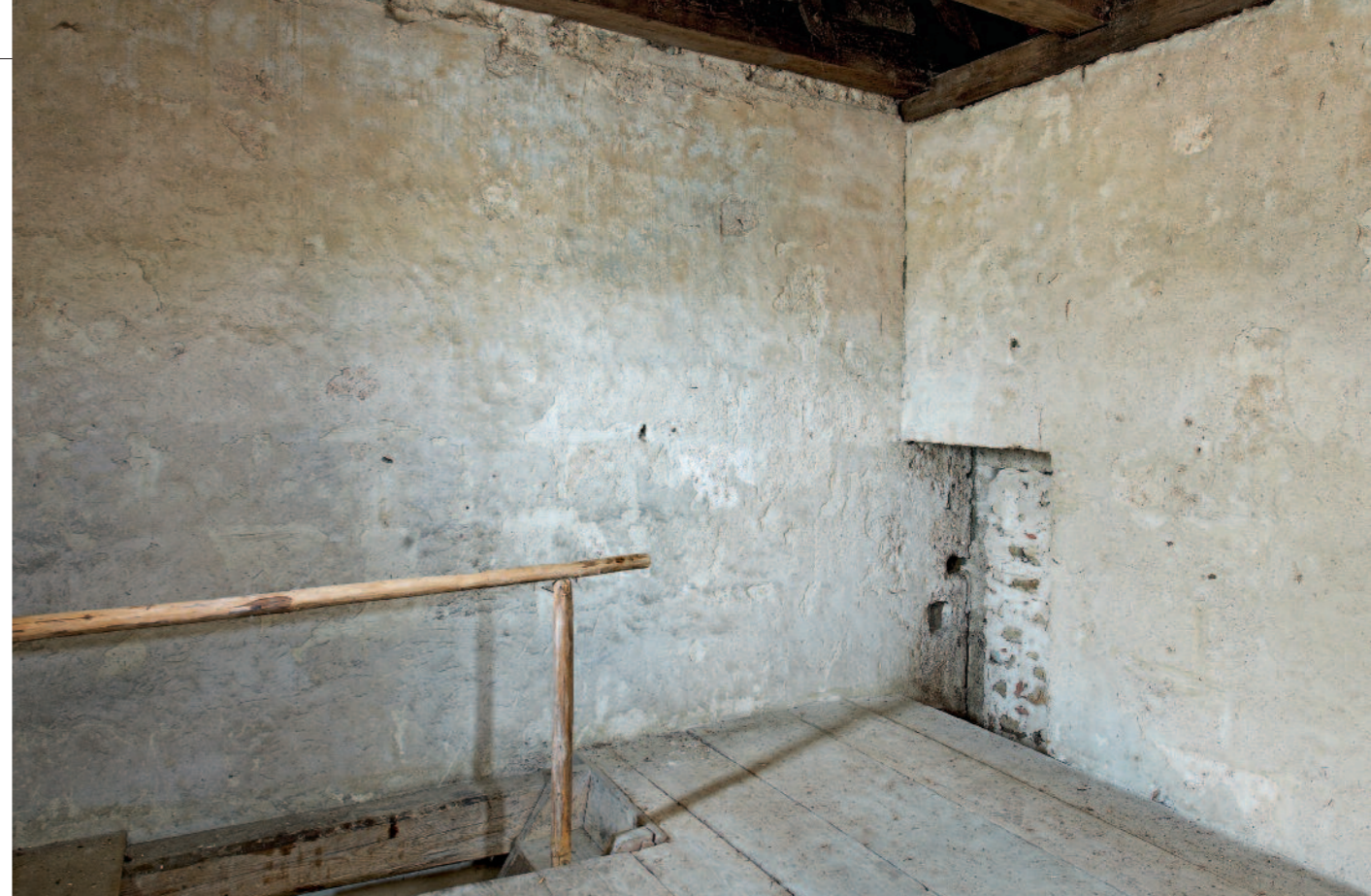
EHEMALIGER EINGANG ZUM OBERGESCHOSS
