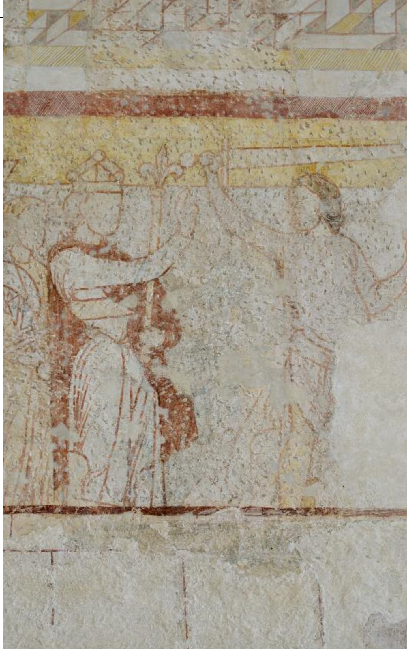
FRESKIERUNG DETAIL ENDZUSTAND
