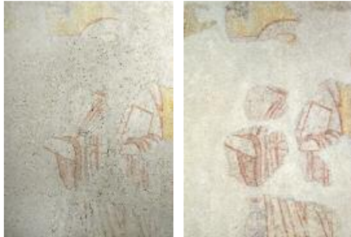
FRESKIERUNG DETAIL, VORZUSTAND ENZZUSTAND
