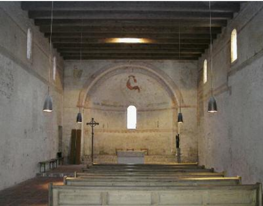
INNENRAUM VORZUSTAND, ANSICHT NACH OSTEN
