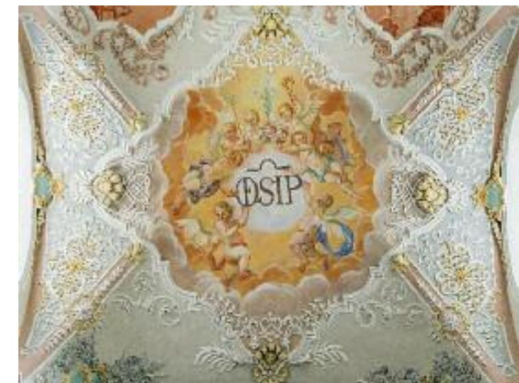
DECKENBILD WESTTEIL LANGHAUS, ENZZUSTAND
