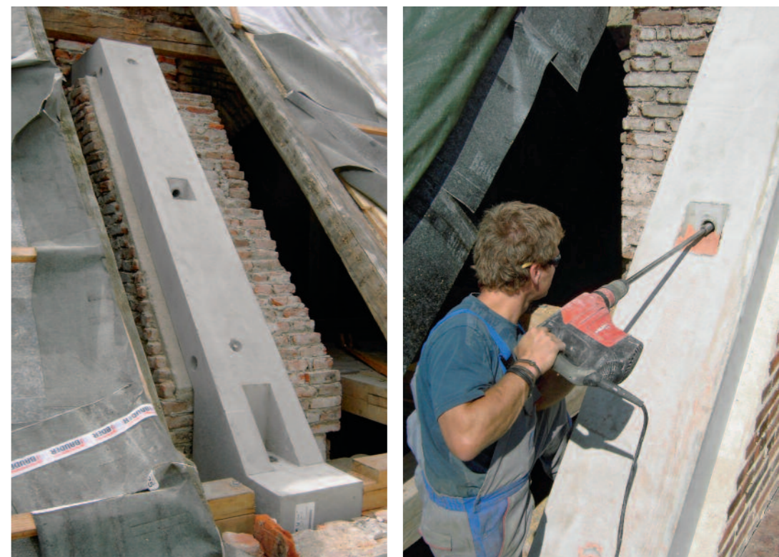
OBEN: DACHSCHUBSICHERUNG ÜBER DEM CHOR UNTEN: MONTAGE FERTIGTEIL ZUR GEWÖLBESICHERUNG
