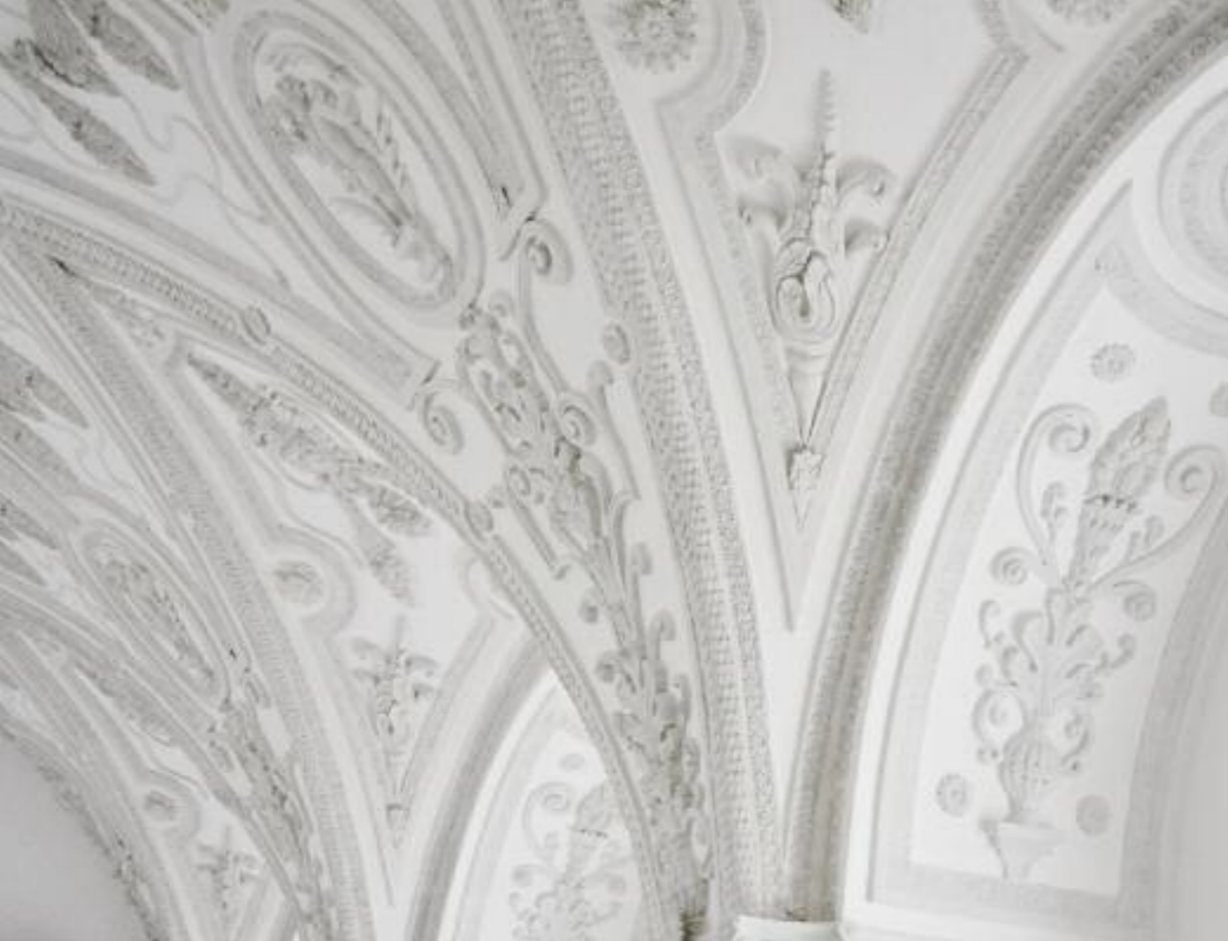
LANGHAUS GEWÖLBE ENDZUSTAND
