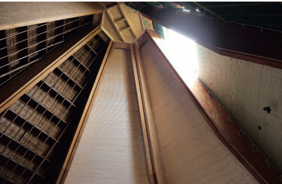
DACHKONSTRUKTION INNEN WÄHREND RENOVIERUNG
