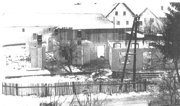
Auf diesem Bild sind nur noch die Mauern der Baracke zusehen. Im Hintergrund ist der Bunker zu erkennen, der heute noch steht.
