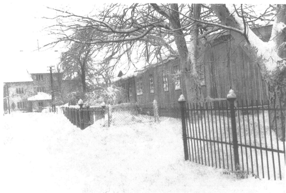
Die Baracken links an der St.-Martin-Straße. An dieser Stelle befindet sich heute das Pfarrheim.
