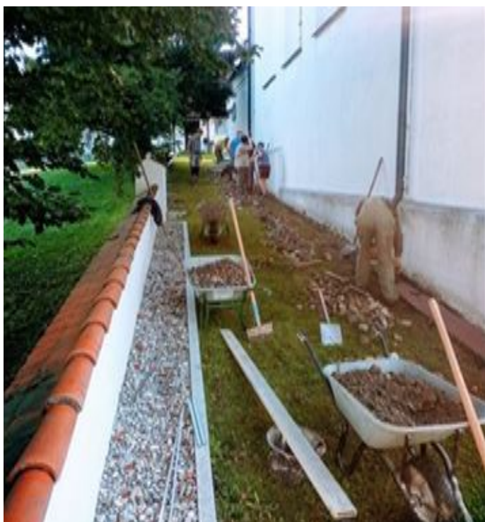
» Arbeiten an der Einfassung der Kirche
