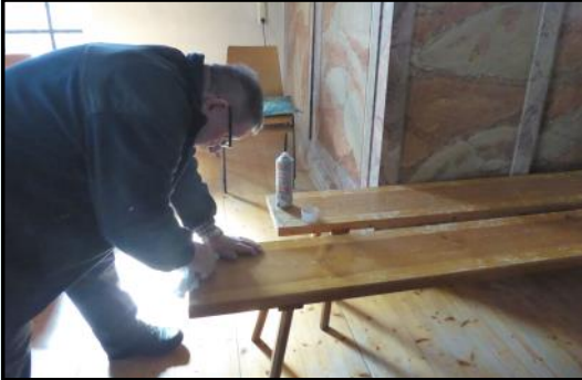
Mühsam mussten die Kleberückstände von den Kirchenbänken entfernt werden.
