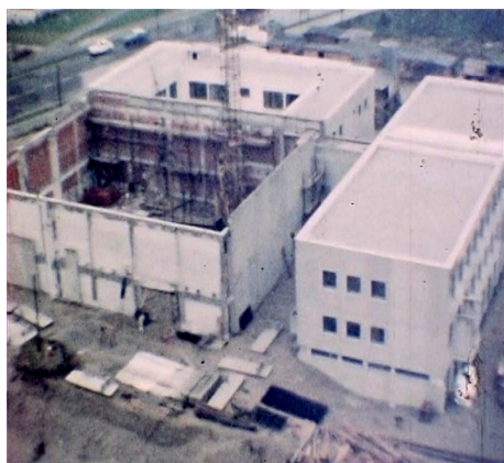
St. Lukas im Bau, hier die Kirche ohne Dach.
