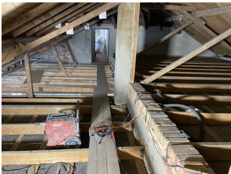
Schadstoffsanierung im Pfarrheim
