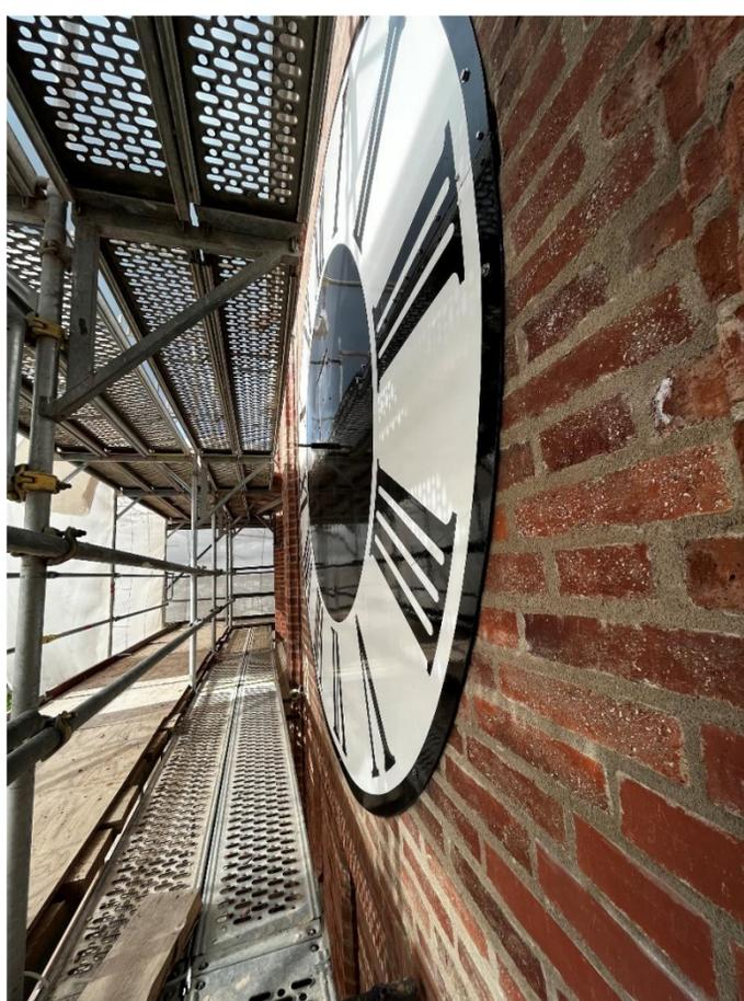
Die Zeiger werden, nach weiterem Rückbau des Gerüsts, wieder montiert. Der Antrieb für das Uhrwerk ist überarbeitet und befindet sich schon im Turm.
