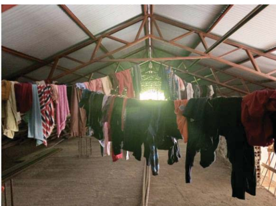
Dachboden des Altenheims
