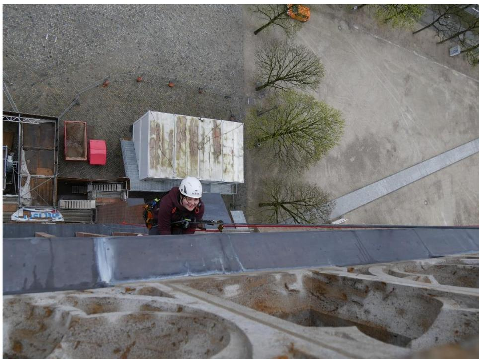
Mittels Schrägseil wurden die Stunden- und Minutenzeiger zu den Kletterern herabgelassen und mit Hilfe eines Mitarbeiters der Fa. Nidermayer, welcher sich innerhalb des Turms in einer kleinen Luke hindurchzwängte und bei der Zeiger Positionierung unterstützte, montiert.
