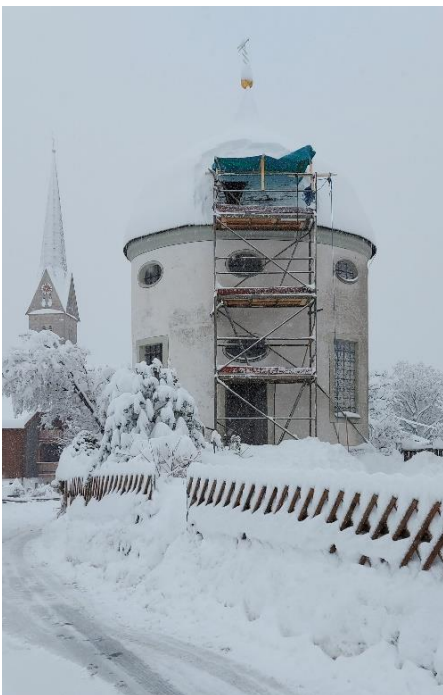
Kapelle mit Gerüst samt Notdach im Schnee
