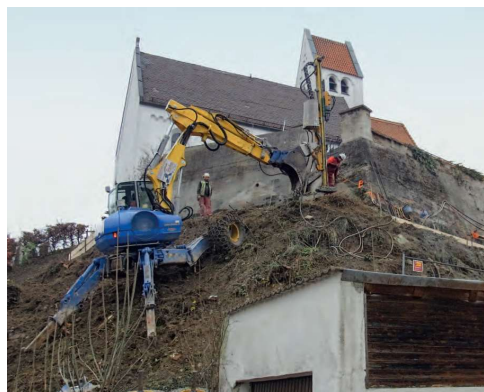
Hebertshausen Alte Pfarrkirche St. Georg Foto: Markus O. Kuntscher
