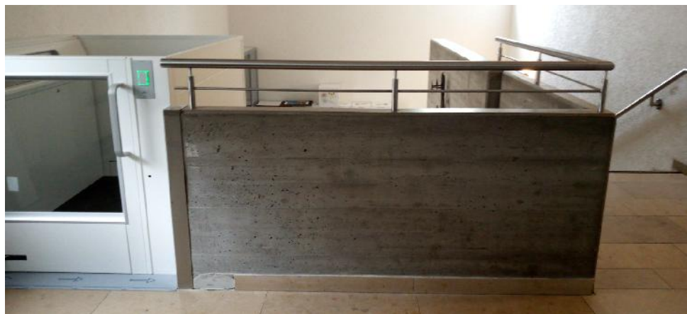
Ein- und Ausstieg oben mit neuem Sicherheitsgeländer auf der Betonbrüstung
