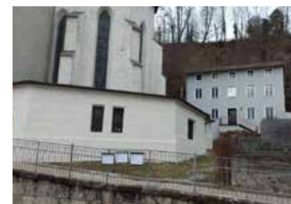
Sockelputz an der Sakristei
