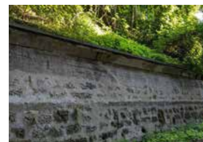
Stützmauer an der Kirche
