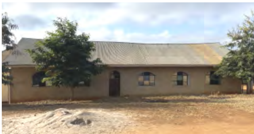
Die jetzige Kirche soll renoviert und erweitert werden
