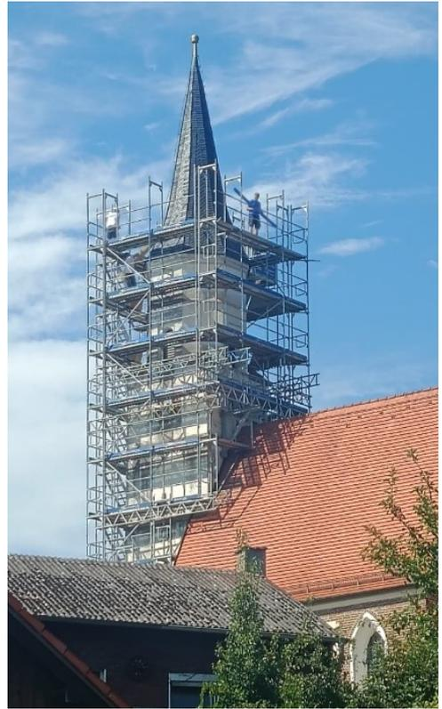
Der damals verwendete Kalkmörtel mit Romananteilen rund um das Turmmauerwerk weist wider Erwarten weniger schadhafte Stellen auf. Diesen damals verwendeten, in der Natur vorgekommene hydraulischen Kalk, gibt es nicht mehr. Für die Ausbesserungsarbeiten wird daher ein Kalk-Zement-Putz aufgebracht. Nach den Putzarbeiten erhält der Turm einen neuen Anstrich.
